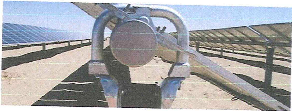
Figura 1-7. Ejemplo de estructura de soporte
